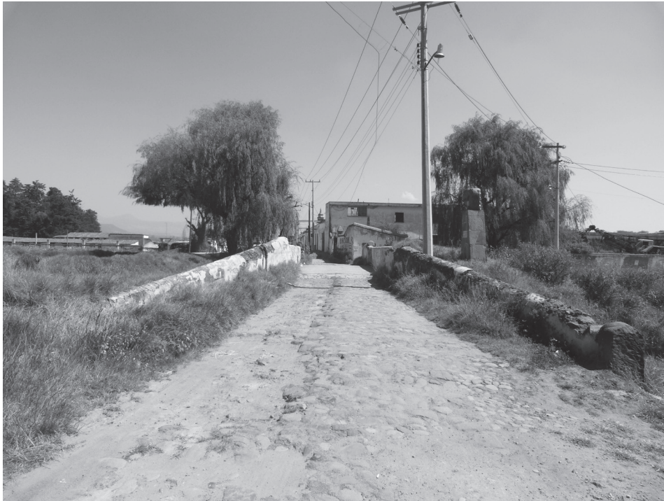
Fotografía 33. Puente de la hacienda de Atenco. Fotografía de Sergio Arellano.
