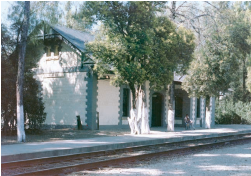
Estación de parada en la vía México-Laredo.
