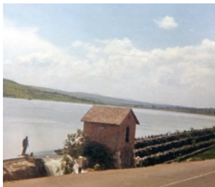
Presa construida en 1906 por Guillermo de Landa, entonces dueño de la hacienda de Xalpa.
