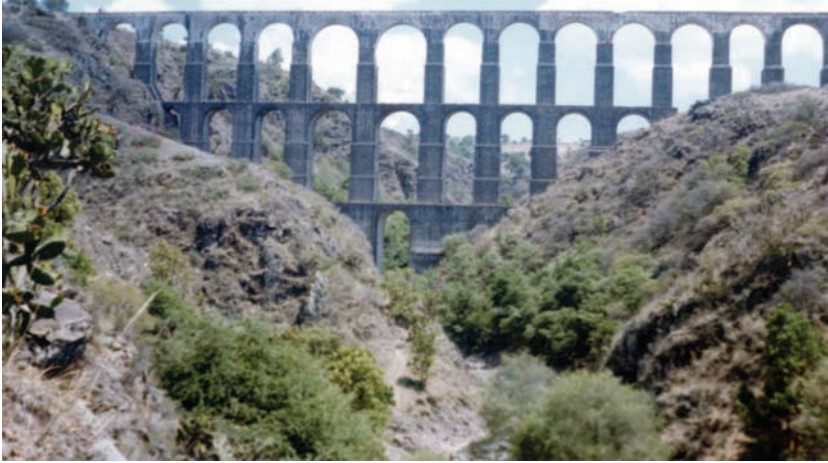
Arcos del Sitio, la obra más importante del acueducto de Xalpa.
