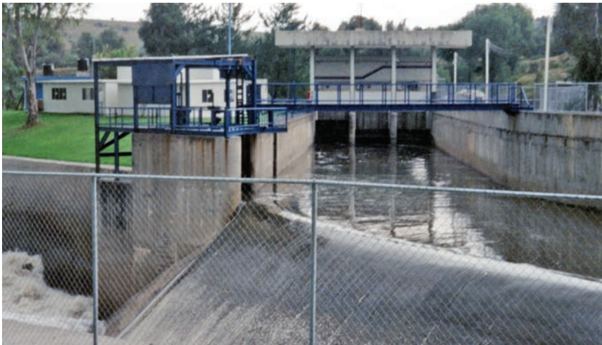
Canal del norte, que lleva las aguas a Tula, Hidalgo.
