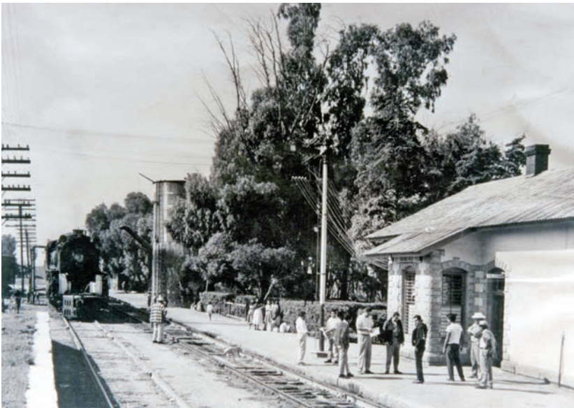
Estación central de la vía México-Guadalajara en la década de los cincuenta.
