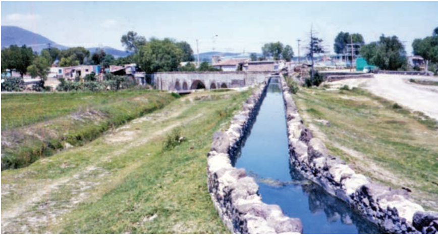
El acueducto, construido con piedra y argamasa, en El Potrero.
