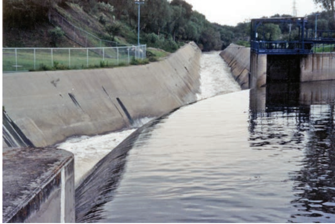
Al final del portal se forma una cascada que descarga en dos canales.
