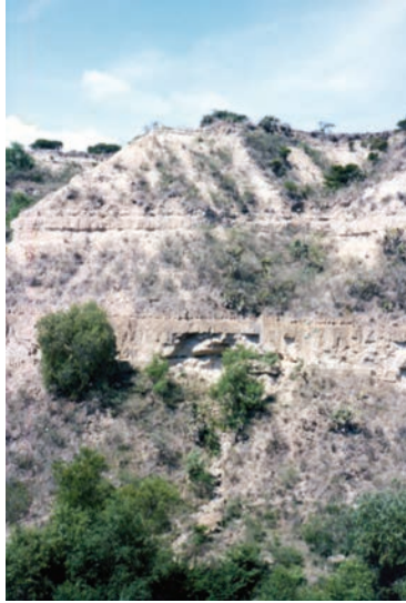
Restos del puente de la Esperanza, obra de ingeniería admirada en todo el mundo.
