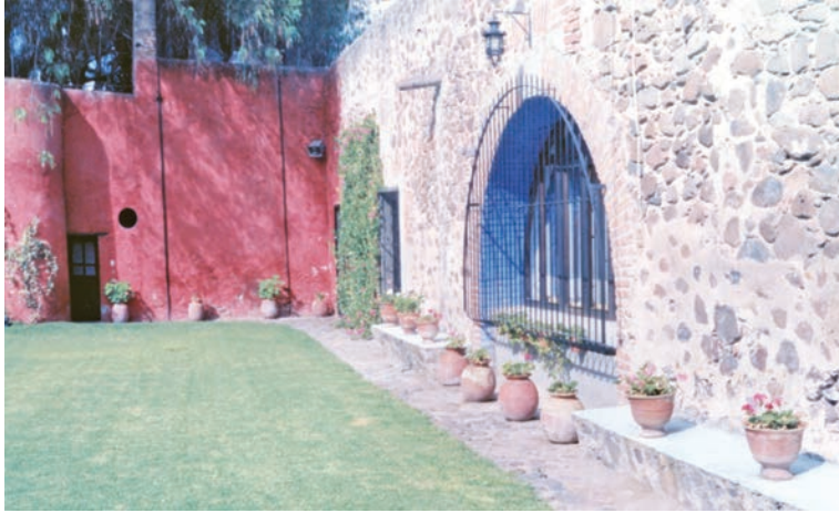
Puerta hacia la alberca exterior.
